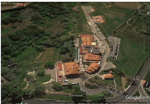
Figura 2 - Vista superior EPAV
